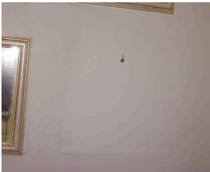
2 | Zwarte afzettingen op de binnenbepleistering van een buitenmuur, wat benadrukt wordt door het wegnemen van een schilderijtje.
